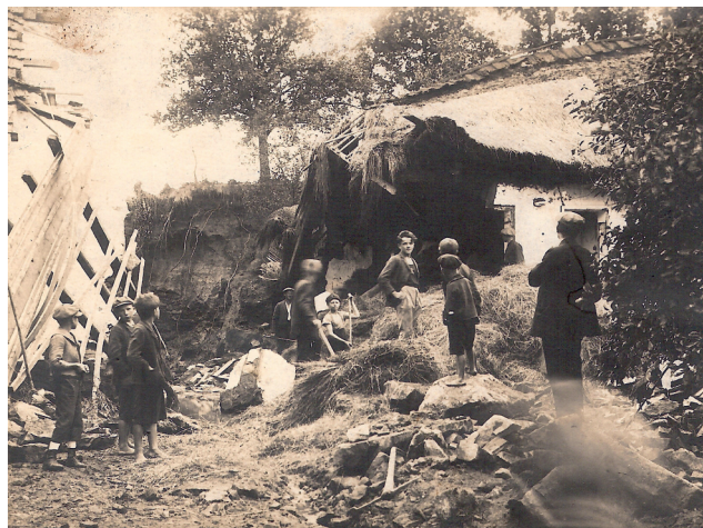
Poškozený Šimáněův mlýn pod městem 12. srpna 1925 (archiv Města Kasejovice)
