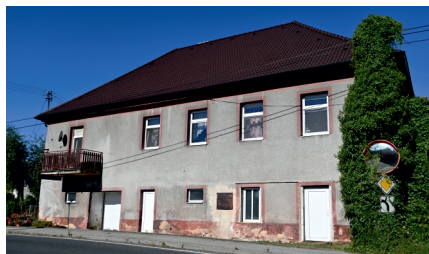
Dům čp. 67 v Oselcích, kde provozovali obchod Nathan a Joachim Gibianové (foto autor příspěvku)
